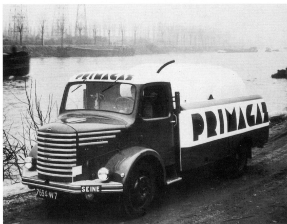
Giterne pour la livraison de gaz liquéfié sur ZU35.
