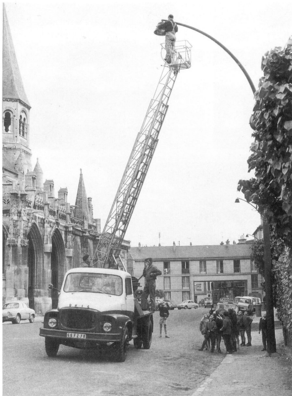
Echelle manuelle de 18 mètres Riffaud pour travaux électriques avec plateforme de travail sur MZ34 Bonhomme.
